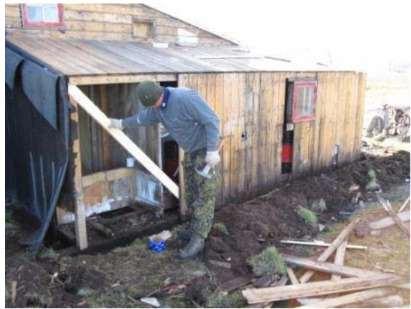
Jens udskifter væggen i bislaget ved toiletet.
