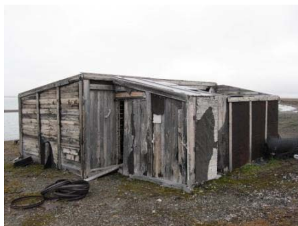
Dobbeltskuret, - klar til nedrivning!
