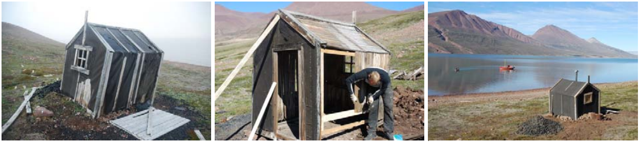
Petrahytten [347] før, under og efter renovering.
